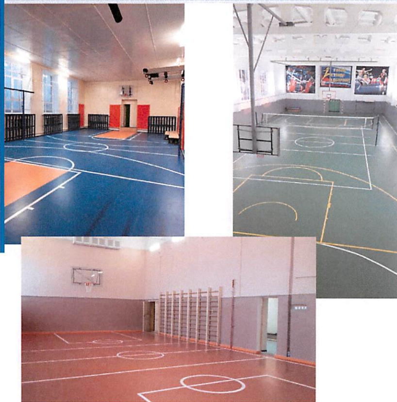
Капитальный ремонт спортивных залов в образовательных учреждениях, расположенных в сельской местности
