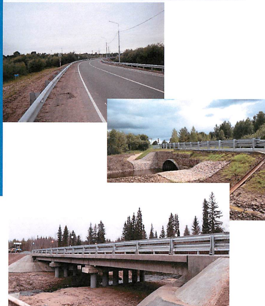
Капитальный ремонт объектов дорожной инфраструктуры
